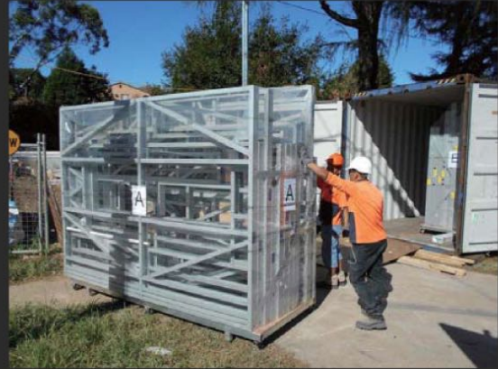
Déchargement sur place.
